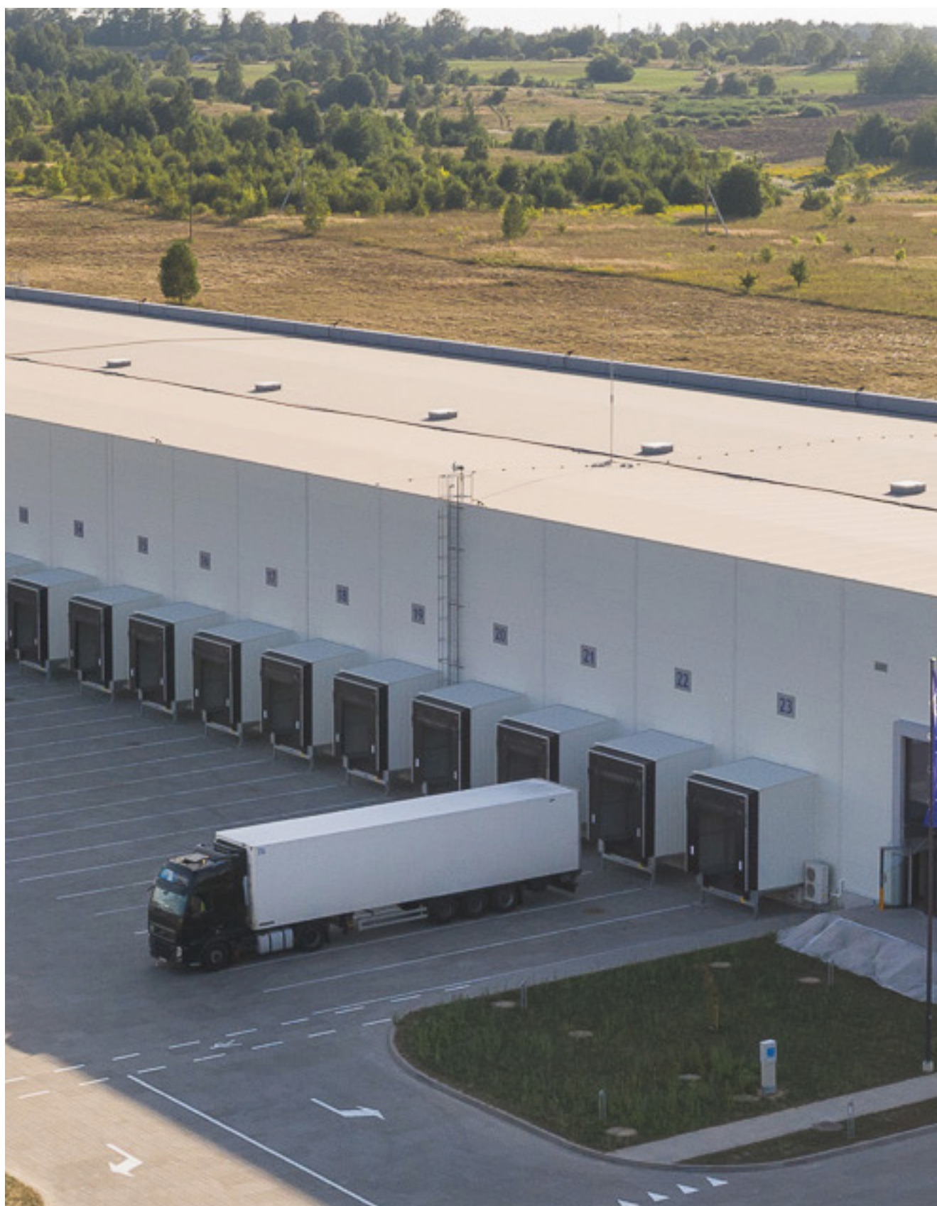
Logistikkterminal overlevert til Delamode i løpet av 2020.
