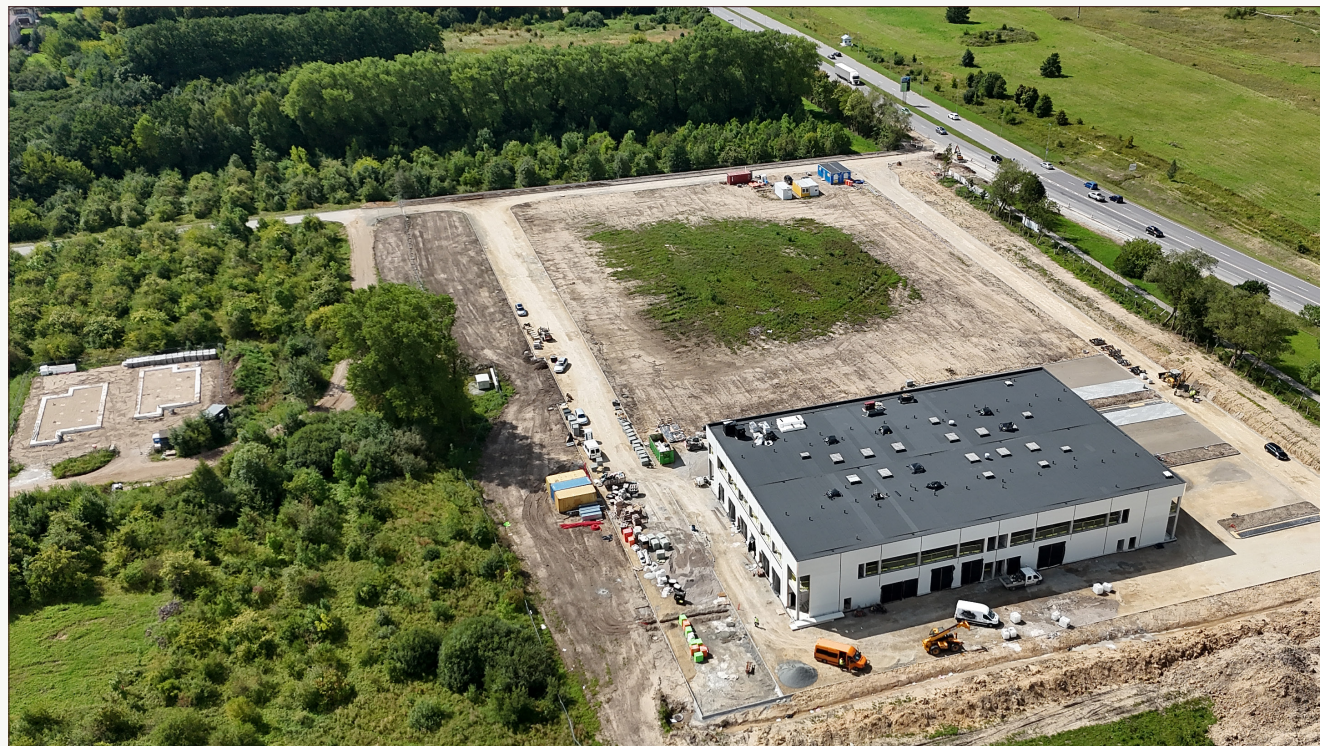
Liepų Parkas | Construction in progress, August 2024
